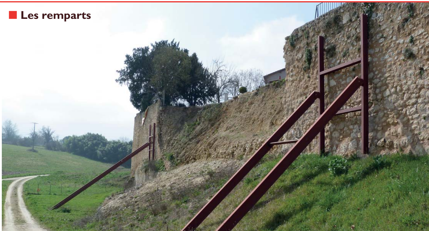
Le soutènement provisoire des remparts.
