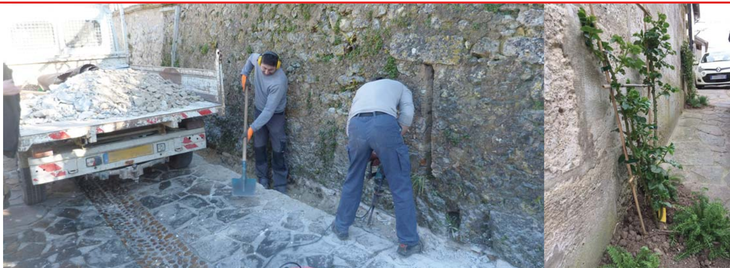
Aménagement des abords de la rue des fours banaux.
