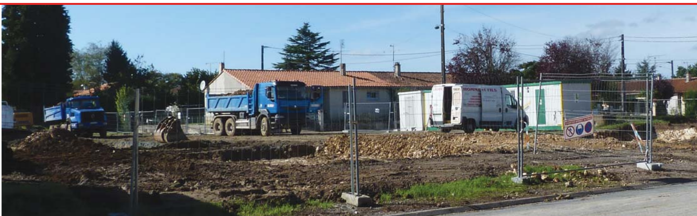
Lotissement des Chenevières.
