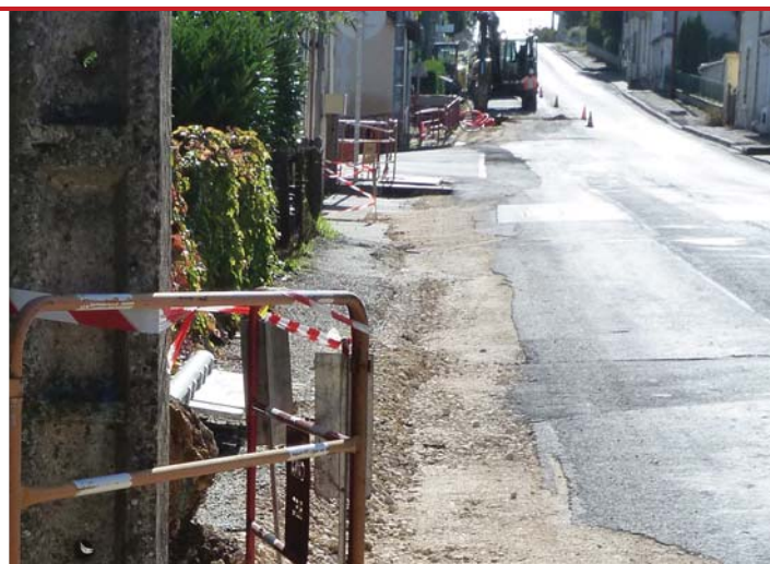
Travaux deuxième tranche.
