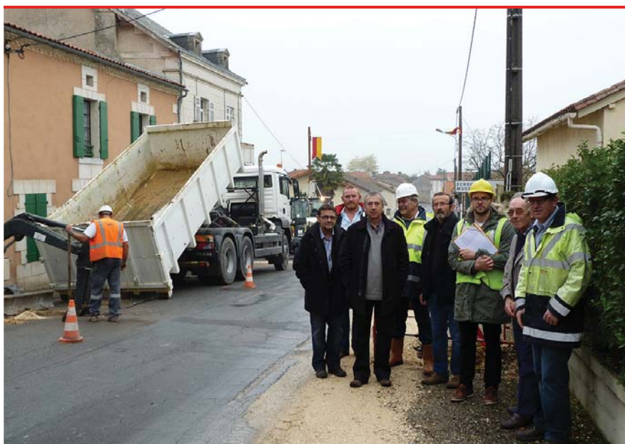
Enfouissement des lignes rue du Dr Ladouch.
